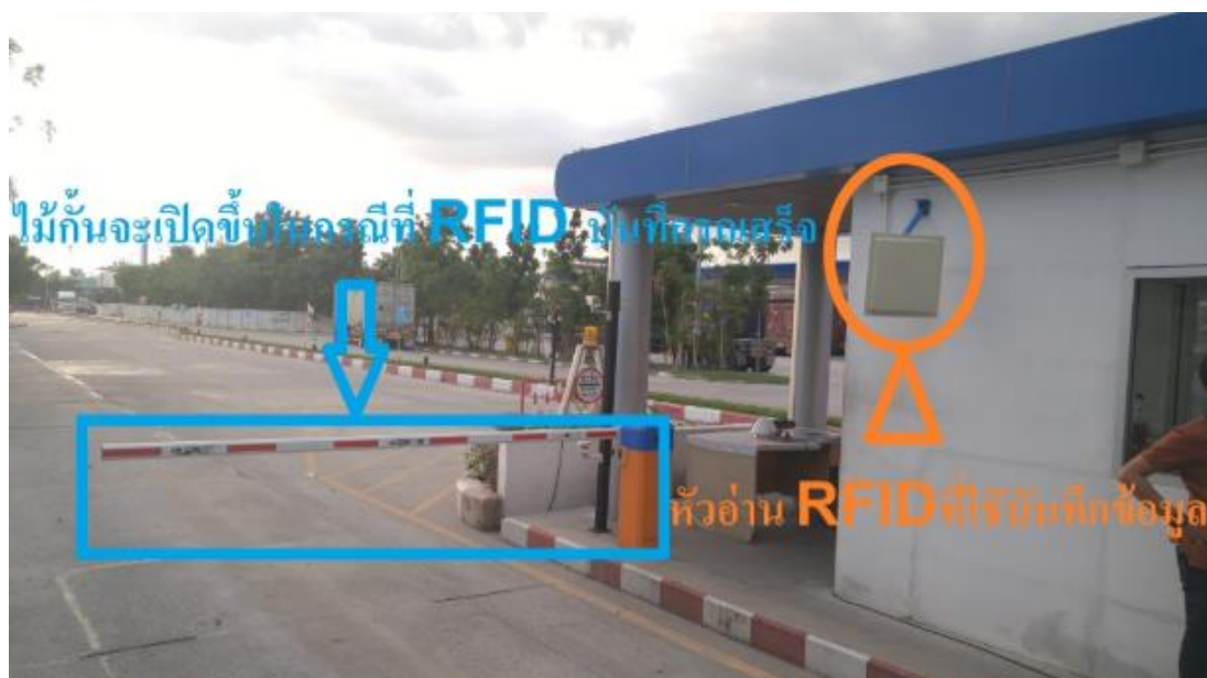
ภาพที่ 3.16 ภาพประกอบการทำงานของระบบ RFID
