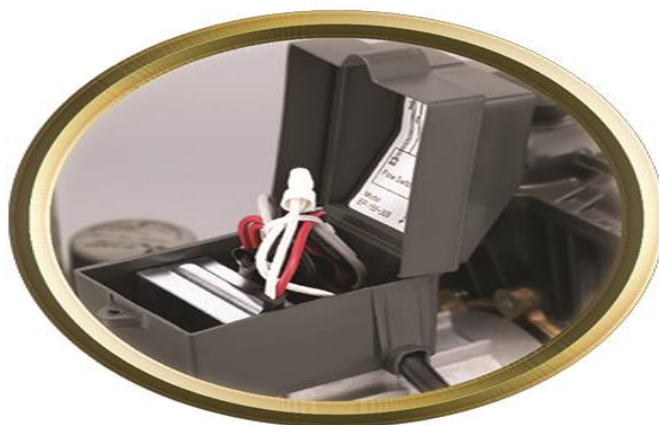
ภาพที่ 2.23 ชุดควบคุม
