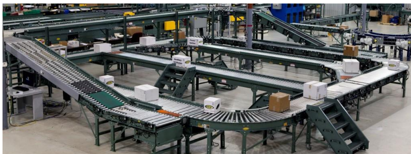
ภาพที่ 3.13 สายพานลำเลียง
