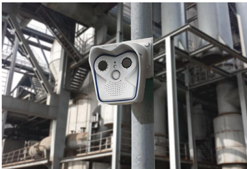
ภาพที่ 3.16 การติดตั้งกล้องวงจรปิดภายในคลัง
