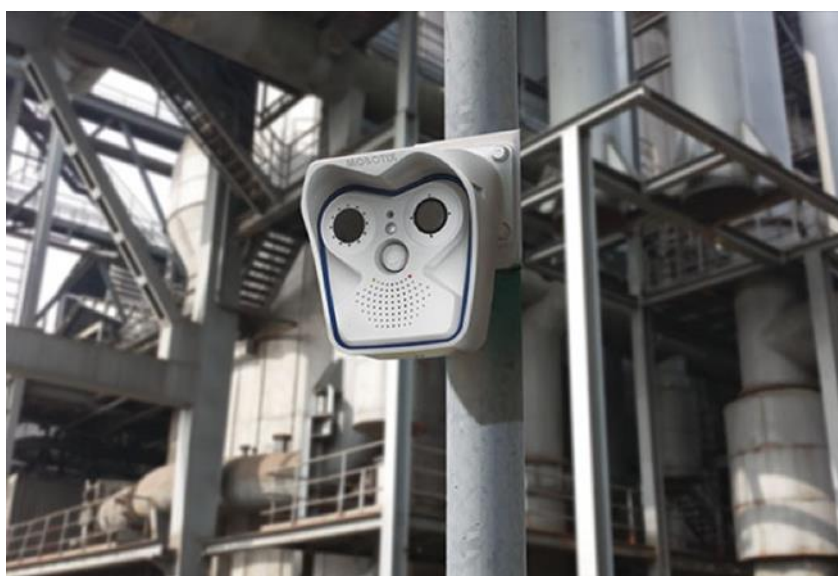
ภาพที่ 4.10 การติดตั้งกล้องวงจรปิด
