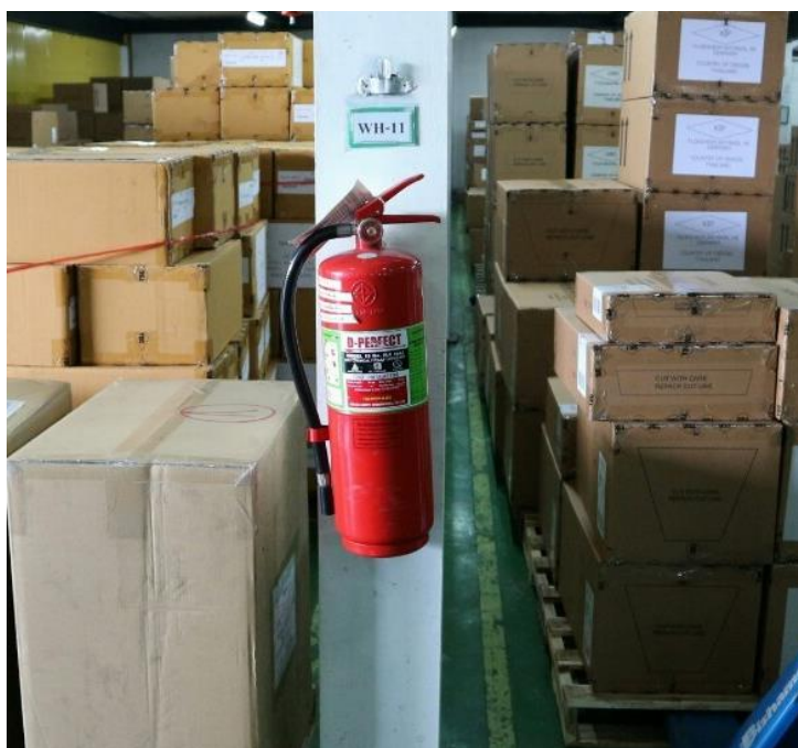
ภาพที่ 4.13 ถังดับเพลิง
