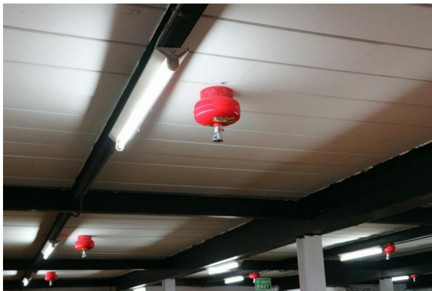
ภาพที่ 4.14 ระบบดับเพลิงแบบหมอกน้ำ
