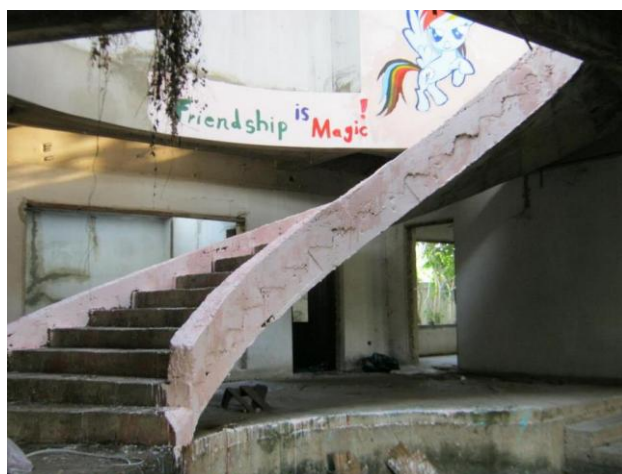
รูปที่ 3.11 ห้องโถง บ้านไวดกลางบ้าน
