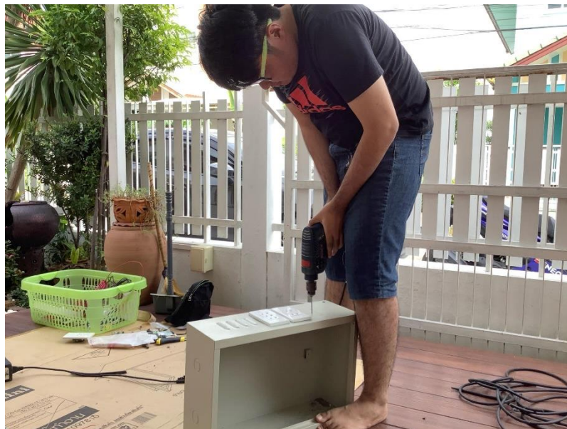
รูปที่ 4.14 นำตู้ไฟมาตัด,เจาะตามขนาดที่วางเอาไว้
