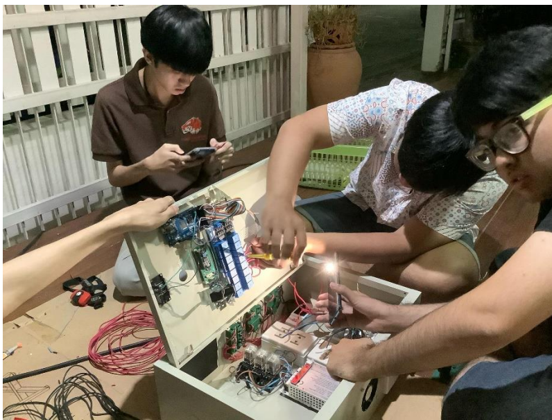
รูปที่ 4.16 ต่อสายวงจรเข้าบอร์ดและต่อเข้ากับไฟ Relay และไฟ 220v
