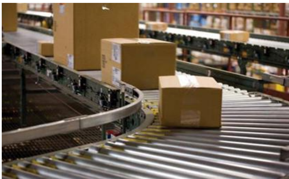
ภาพที่ 3.35 สายพานลำเลียง
