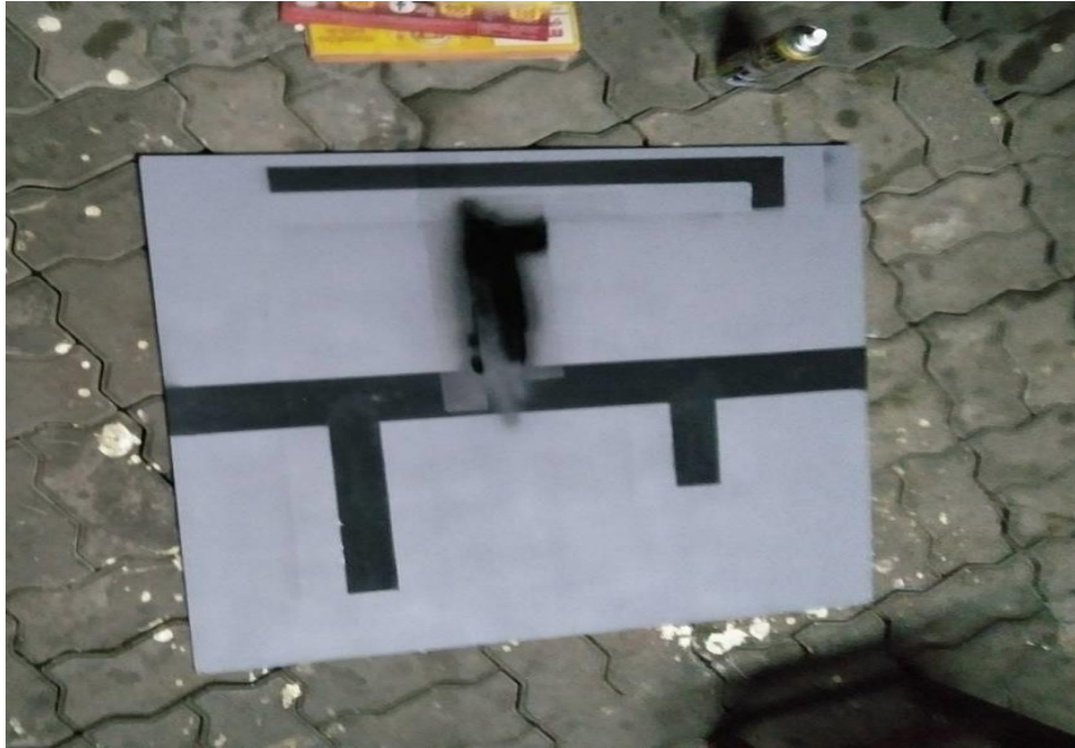
นำสีดำมาพ่นสีถนนตามที่แบ่งและวาดร่างไว้
