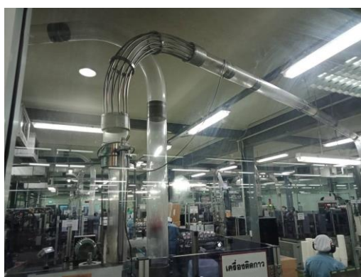
ภาพที่ 4.4 ท่อลมที่ลำเลียงถ้วยกระดาษ
